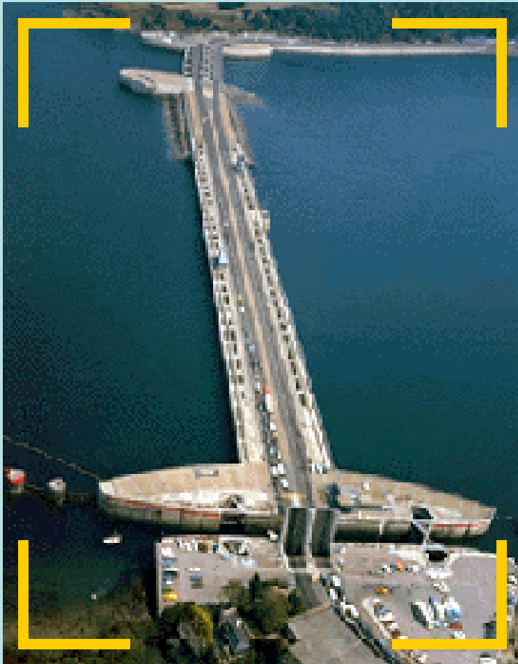
La Rance tidal barrage
